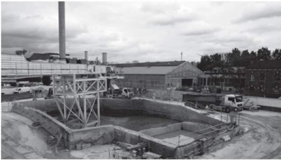
(1) L'ensemble des terres ont été prélevées et sélectionnées sur des chantiers franciliens entre mai et juin 2016, dont certaines à Saint-Duen, sur le chantier du prolongement de la ligne 14 de la Ratp.
