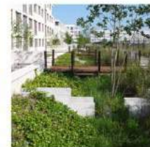
Bassins filtrants eaux voirie et toitures
