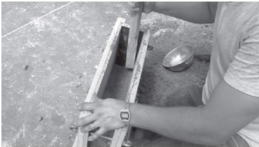
(21) Le compactage réalisé à l'aide d'un piseur manuel ou mécanique fait diminuer d'environ 1/3 la hauteur de chaque lit.
