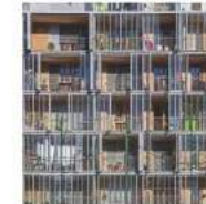
QUARTUS avec Lipsky+Rollet pour des logements à énergie positive Amplia à Lyon Confluence
