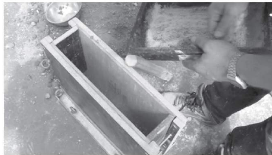
(22) Des couches d'argile plus claire mélangée à des limons (silts) et sables très fins sont rajoutées afin de mieux lire les strates de terre. En construction, il est possible d'incorporer différents matériaux afin par exemple de mieux maîtriser l'érosion (tuiles ou lits de chaux).
