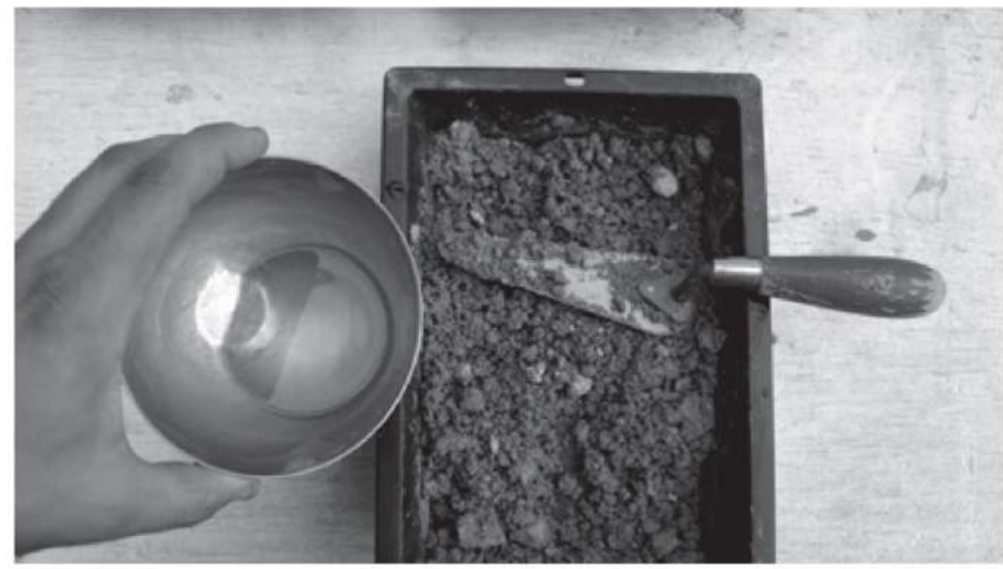
(14) Cet apport en eau s'effectue précisément pour éviter tout risque de fissuration au séchage, mais aussi en fonction des techniques de mise œuvre envisagées (compactage, coulage, lissage...).
